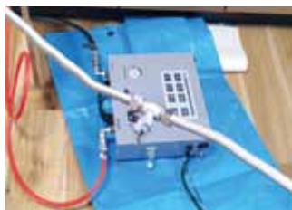
② コントローラー設置
