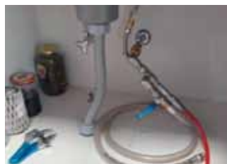
③ 打込口取付
